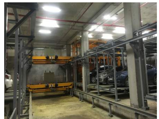
Kết cấu thép 2 tầng (Steel structure)
