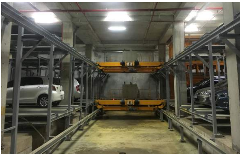
Hai bàn dịch chuyển hoạt động độc lập (Two independent shuttles)
